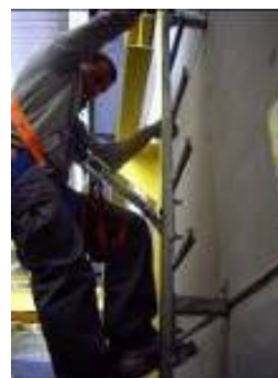
Figura 20.- Descenso con dispositivo anticaídas deslizante
