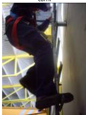
Figura 9.- Ascenso con dispositivo anticaídas deslizante
