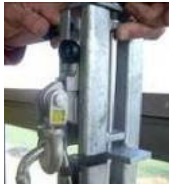
Figura 9.- Ascenso con dispositivo anticaídas deslizante
