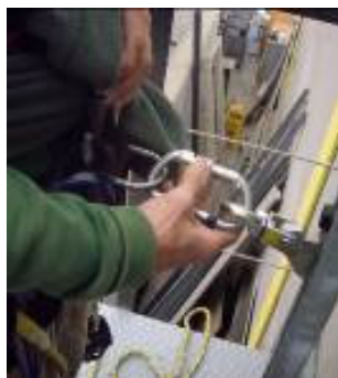
Figura 21.- Desconexión del carril del dispositivo anticaídas deslizante
