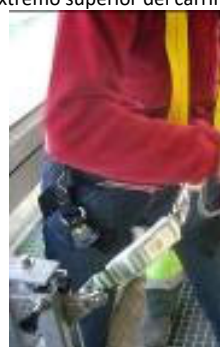
Figura 18.- Anclarse al dispositivo anticaídas deslizante
