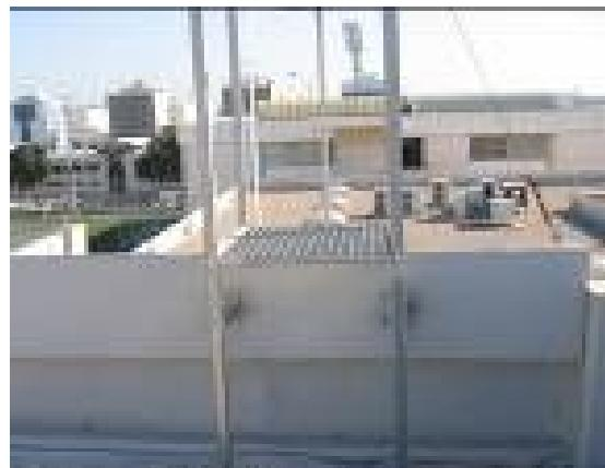
Desde las escaleras de acceso a equipos de climatización al carecer las escaleras de protección mediante barandillas. En ocasiones estas escaleras están próximas al borde de la cubierta.
