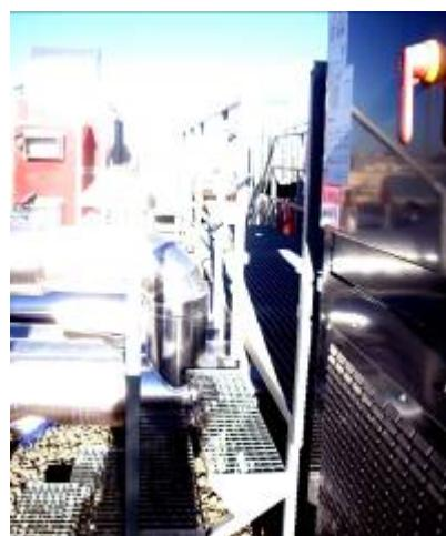
Escaleras para trabajar en los equipos de climatización deficientemente apoyadas sobre el suelo de la cubierta.
