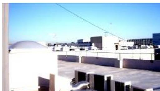
Claraboyas elevadas a 150 cm del nivel de la cubierta. Las claraboyas próximas a equipos de climatización disponen además de protección mediante emparrillado metálico.
