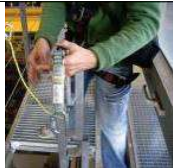
Figura 16.- Colocar el dispositivo anticaídas deslizante en el extremo superior del carril
