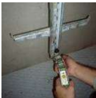
Figura 7. Instalación del dispositivo anticaídas deslizante en el carril
