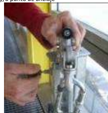
Figura 10.- Conexión del extremo libre del elemento de amarre a placa y/o punto de anclaje
