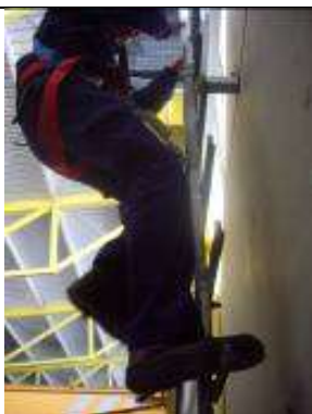
Figura 9.- Ascenso con dispositivo anticaídas deslizante
