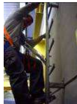
Figura 20.- Descenso con dispositivo anticaídas deslizante
