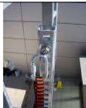
Figura 10.- Conexión del extremo libre del elemento de amarre a placa y/o punto de anclaje
