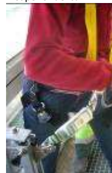
Figura 18.- Anclarse al dispositivo anticaídas deslizante
