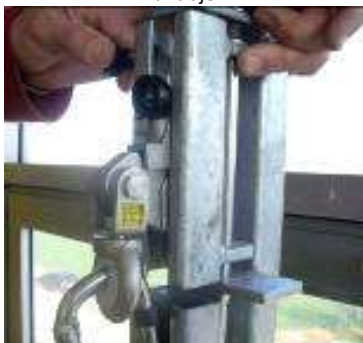
Figura 17.- Alineación del carril
