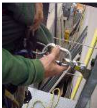
Figura 21.- Desconexión del carril del dispositivo anticaídas deslizante
