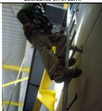
Figura 7.- Ascenso con dispositivo anticaídas deslizante Tipo AL-R
