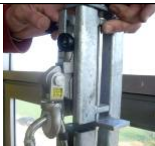
Figura 16.- Alineación del carril
