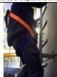
Figura 19.- Descenso con dispositivo anticaídas deslizante Tipo AL-R
