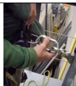
Figura 21.- Desconexión del dispositivo anticaídas deslizante
