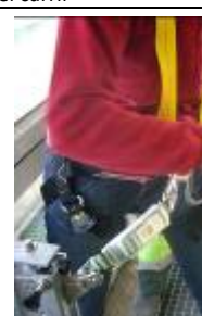
Figura 17.- Anclarse al dispositivo anticaídas deslizante
