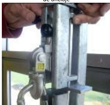
Figura 17.- Alineación del carril
