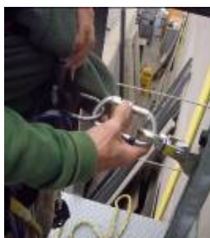
Figura 21.- Desconexión del carril del dispositivo anticaídas deslizante
