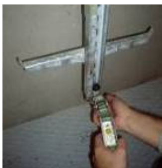
Figura 7. Instalaci3n del dispositivo anticaídas deslizante en el carril
