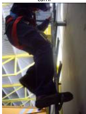
Figura 9.- Ascenso con dispositivo anticaídas deslizante
