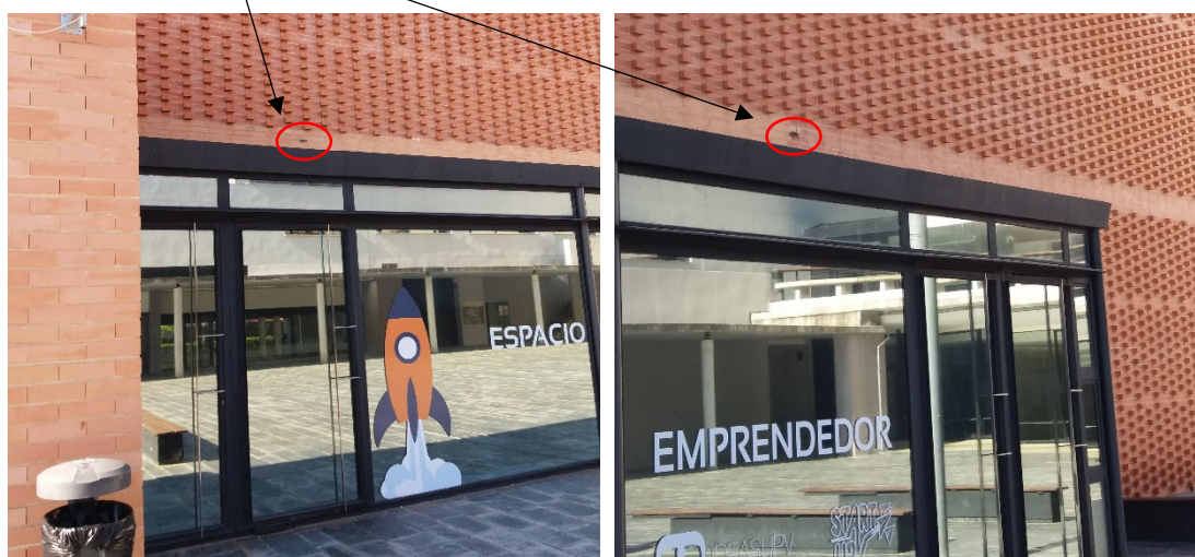
Detalle de situación de anclajes
