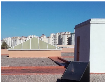
Fotografía 1. Vano de iluminación elevado y sobrecubierto a la derecha.
