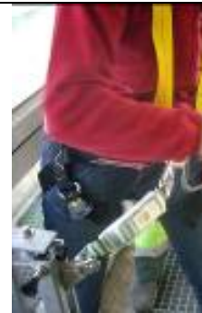
Figura 17.- Anclarse al dispositivo anticaídas deslizante
