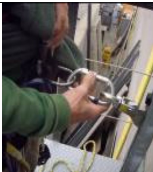
Figura 20.- Desconexión del carril del dispositivo anticaídas deslizante
