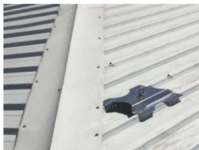
Fotografía 1. Anclaje estructural EN 795 A (punto antibalaneo)
