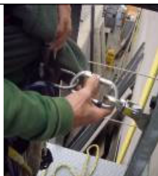
Figura 20.- Desconexión del carril del dispositivo anticaídas deslizante
