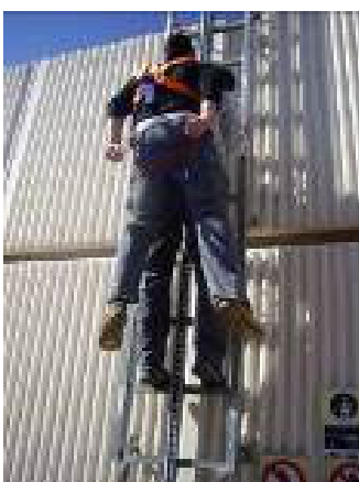
Figura 25.- Paso 3: Pequeño impulso hacia arriba para desbloquear el dispositivo anticaídas deslizante
