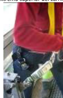
Figura 18.- Anclarse al dispositivo anticaídas deslizante
