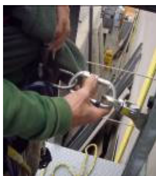
Figura 21.- Desconexión del carril del dispositivo anticaídas deslizante
