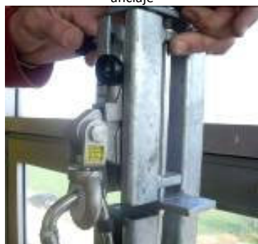
Figura 17.- Alineación del carril
