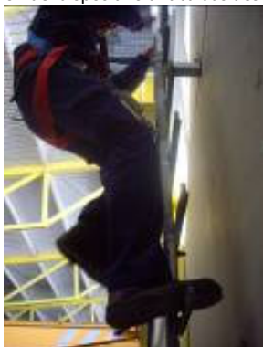
Figura 9.- Ascenso con dispositivo anticaídas deslizante
