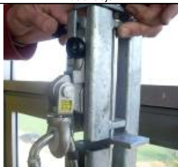
Figura 16.- Alineación del carril
