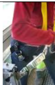
Figura 17.- Anclarse al dispositivo anticaídas deslizante
