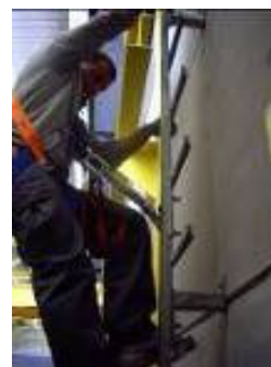
Figura 20.- Descenso con dispositivo anticaídas deslizante
