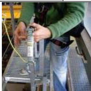
Figura 16.- Colocar el dispositivo anticaídas deslizante en el extremo superior del carril
