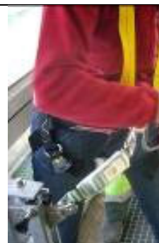
Figura 17.- Anclarse al dispositivo anticaídas deslizante
