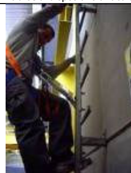
Figura 17.- Anclarse al dispositivo anticaídas deslizante
