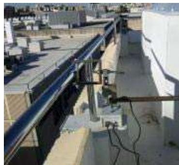
Elevación de todas las claraboyas a 140 cm sobre el nivel de la cubierta.
