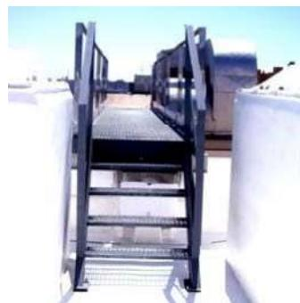
Instalación de 168 m de barandilla recta autoportante según EN 14122-3 a lo largo de todo el perímetro de las dos cubiertas este.
