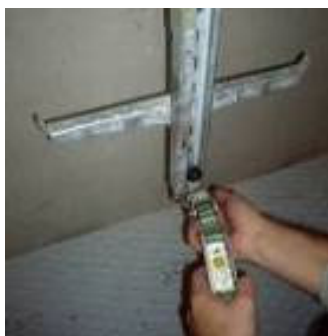
Figura 7. Instalaci3n del dispositivo anticaídas deslizante en el carril
