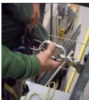
Figura 21.- Desconexión del carril del dispositivo anticaídas deslizante
